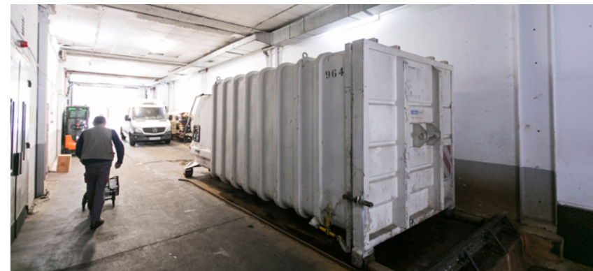
Mercado de Santa María de la Cabeza Compactadora de residuos en la zona de logística.
