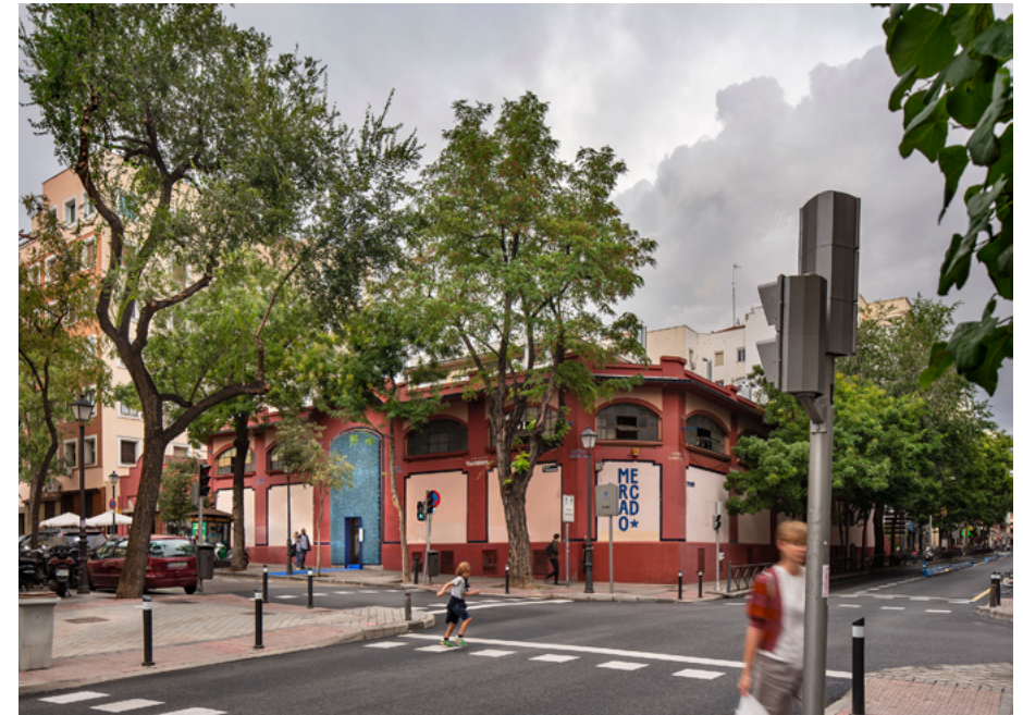
Portal Vallehermoso Fotografías del prototipo construido
